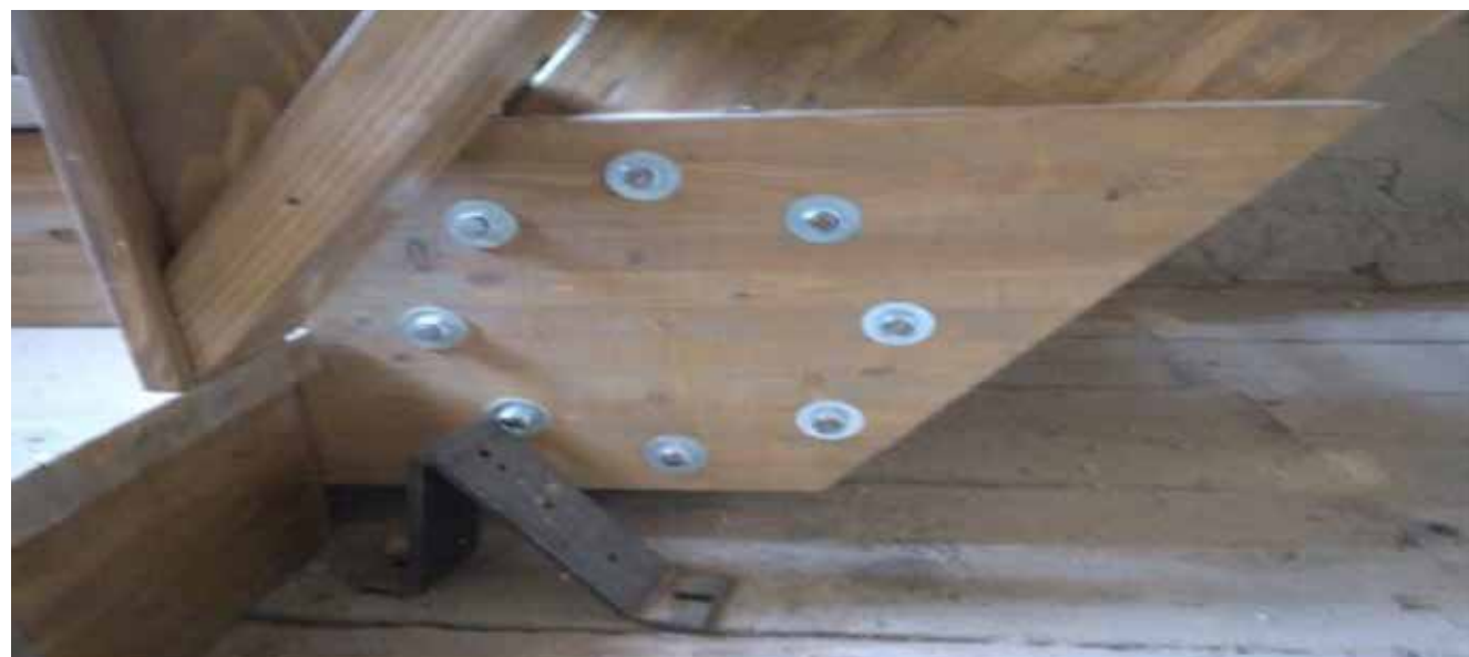
Nyomatékvitel merevszög esetén csavarkötéssel
