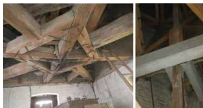
Szerkezeti megoldások a toronysisakban
