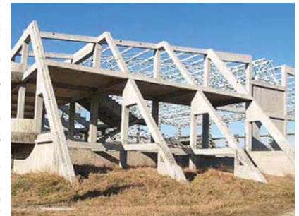
Масивна конструкција базена у изградњи
