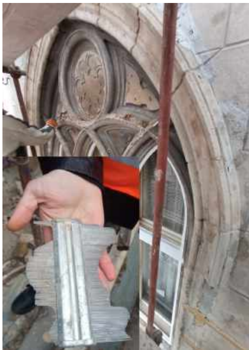
Keretek és bordúrok profilgörbületének mérése
