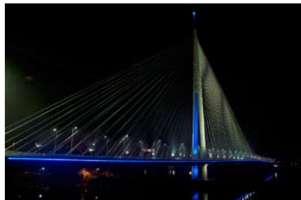
Завршена изградња Моста на Ади
