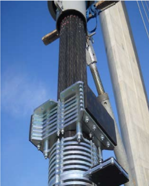
Радови на изградњи моста
